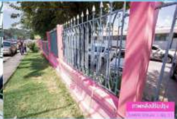
ภาพก่อนปรับปรุง
